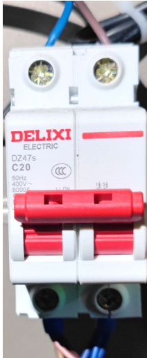
图4-3 空开接线图
