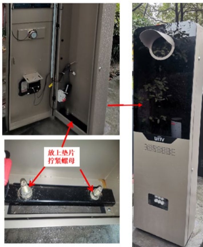
图3-2 安装示意图
